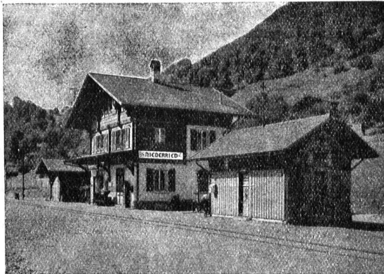
Station der Brienzerseebahn. Eternit-Doppeldach, kupferbraun
