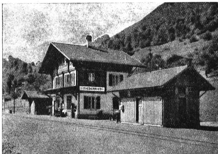
Station der Brienerseebahn. Eternit-Doppeldach, kupferbraun
