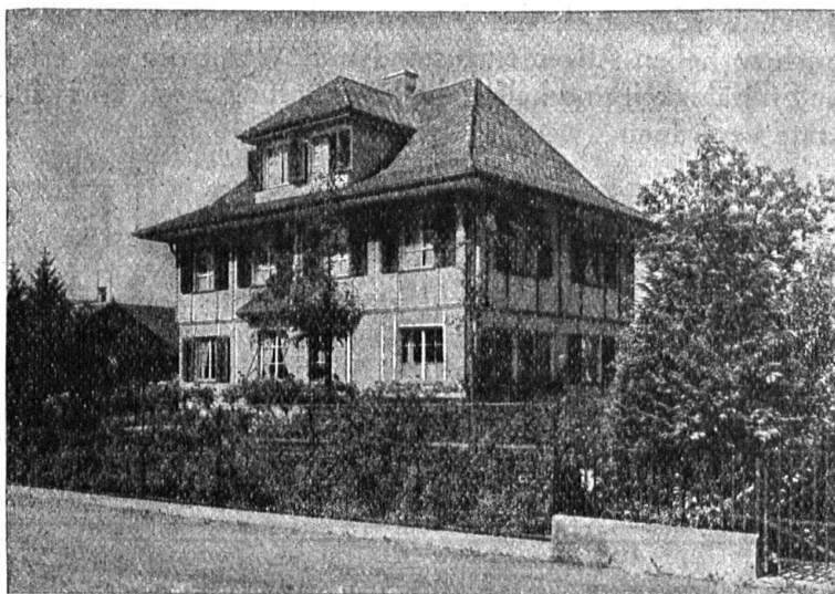
Eternithaus in Winterthur, nach System Fritschi & Zangerl, Architekten. Bedachung: Eternit-wagrechte Deckung, kupferbraun. Fassade: Grosse Eternitplatten.
