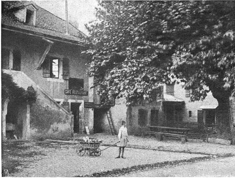
Abb. 18. Gutes Beispiel einer alten Genfer Landbaute, die in Cartigny als Wirtshaus dient. Schade, dass das Dach durch die elektrische Leitungstange entstellt wird. — Fig. 18. Dèlicieux exemple de vieille demeure genevoise servant d'auberge à Cartigny. Le toit est malheureusement enlaidi par la lourde tige en fer de l'éclairage électrique.
