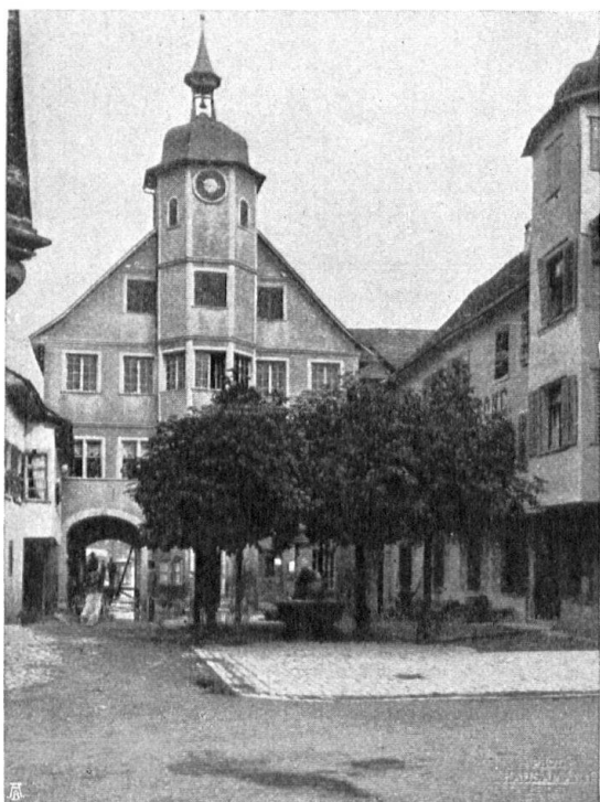
Abb. 18. Das Rathaus in Steckborn. Das alte Riegelwerk wurde im Jahre 1863 übertüncht. Aufnahme Hausmann, Heiden. — Fig. 18. L'hôtel de ville, à Steckborn. Les murs de l'ancien bâtiment en pans de bois ont été recouverts en 1863 d'un épais crépi.
