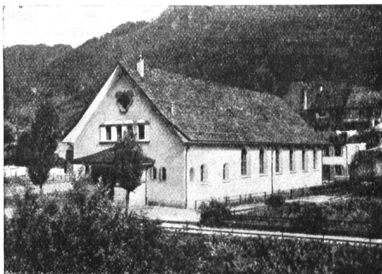
Turnhalle in Glarus, Eternit Doppeldach, schwarz engobiert
