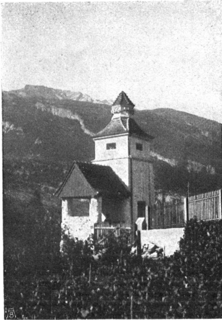
Abb. 12. Gutes Transformatorhaus. — Fig. 12. Bon exemple de cabine de trans- formateur.
