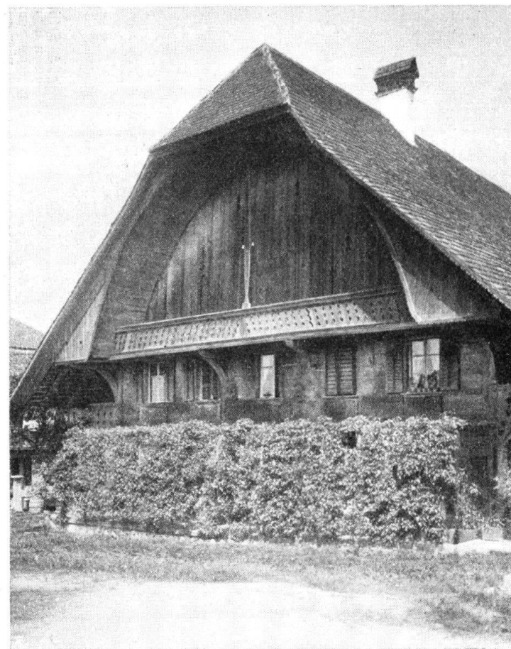
Abb. 8. Wichtrach, Ständerbau. Fig. 8. Wichtrach, Murs de poutres verticales.
