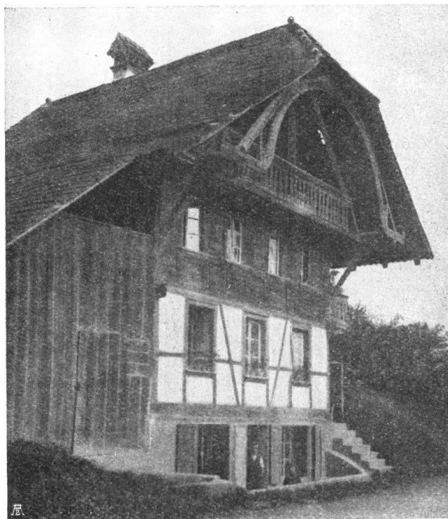
Abb. 11. Heimberg. Haus mit Ständerwand über Fachwerk. Die Konstruktion des sonst immer verschalteten Giebels ist hier sichtbar. — Fig. 11. Heimberg. Murs en pans de bois dans la partie inférieure en poutres verticales dans la partie supérieure. La construction du pignon est ici à découvert.
