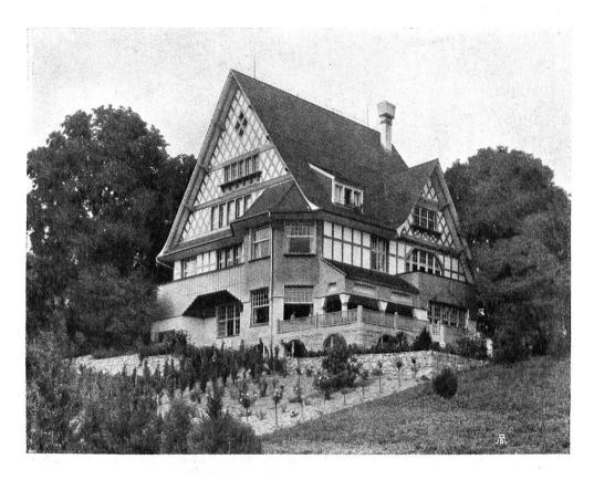
Abb. 11. Modernes Landhaus, bei dem Fachwerkbau, Schindeln und Holzverschalung Verwendung fanden. Landhaus Obereggbühl bei Höngg (Kanton Zürich). Architekt Max Müller, z. Z. Gemeindebaumeister in St. Gallen. — Fig. 11. Villa moderne. L'architecte s'est servi de motifs d'architecture indigène: murs en colombage, revêtement de boiseries et de clavins. Maison de campagne à Obereggbühl, près Höngg (Zurich). Architecte Max Müller, actuellement architecte de la ville, St-Gall.
