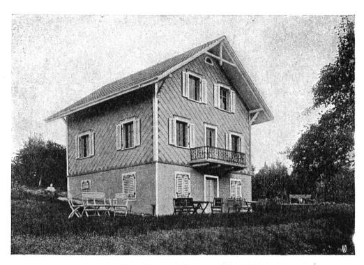
Abb. 12. Gegenbeispiel. Eternit als Wandbekleidung in der hässlichen diagonalen Anordnung grösserer Platten. Aus der Eternitbroschüre des B.S.A. — Fig. 12. Mauvais exemple. Revêtement d'éternite, grandes plaques rangées sans goût en longues diagonales laides et monotones. Reproduction tirée de la brochure sur l'éternite du B.S.A.
