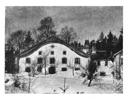
Abb. 16. Gegenbeispiel. Falsche Anwendung der Giebelverschalung des Bernerhauses auf das flache keltoromanische Haus. Eines der letzten jurassischen Bauernhäuser in La Chaux-de-Fonds. – Fig. 16. Mauvais exemple. Application fautive du pignon de la maison bernoise à un bâtiment celtoroman. Une des dernières constructions rustiques de La Chaux-de-Fonds.
