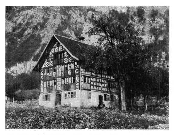
Abb. 7. Fränkisches Haus. Fachwerkbau in Netstal, Kanton Glarus. Aufnahme von Schobinger und Sandheer, St. Gallen. — Fig. 7. Maison franconienne. Construction en colombage, Netstal, canton de Glaris.
