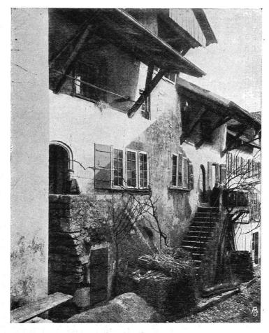
Abb. 9. Steinbauten in Twann, mit weiten, dem Holzbau entstammenden Dachausladungen. Besondere Ausbildung der Traufe und des Estrichloches. Aufnahme von R. Minder, Biel. — Maisons en pierres à Douanne. Les avant-toits, très larges, sont un souvenir des anciennes constructions en bois. Remarquer le développement qu'ont pris les gouttières et les combles.
