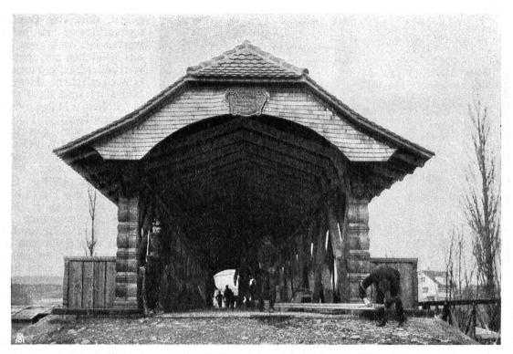
Abb. 20. Brückenkopf der hölzernen Birsbrücke in Münchenstein. Mit Holzschnitzerei, Schindelvorschirm und Ziegeleindeckung. – Fig. 20. Tête du pont de Münchenstein. Sculptures en bois. Toiture de tuiles. Parois protectrices en clavins.
