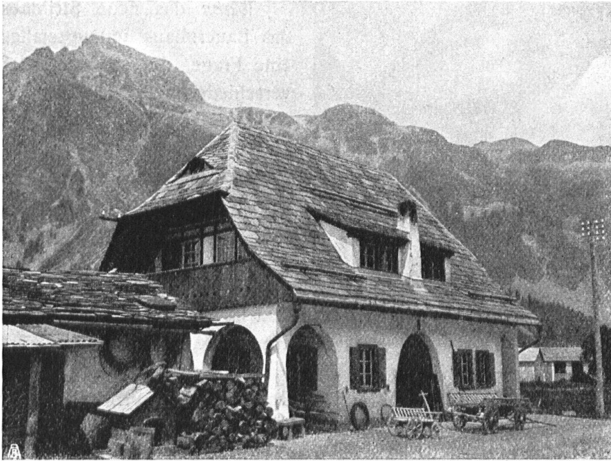
Abb. 11. Schmiede in Sils-Maria. Verschiedene Formen von Dachlichtern im Schieferdach, das hier, über einem guten Neubau, besonders schön durchgebildet ist. Erstellt von Baumeister Kuhn in Sils. Aufnahme von Frau L. Stumm , Basel. — Fig. 11. Forge à Sils-Maria. Différentes formes de lucarnes dans un beau toit d'ardoises en harmonie avec une nouvelle construction pleine de caractère. Architecte Kuhn à Sils.
