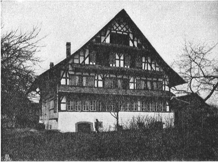
Abb. 10. Riegelhaus in Hombrechtikon. Aufnahme von Dr. Fehr, Zürich. Fig. 10. Maison en pans de bois à Hombrechtikon.
