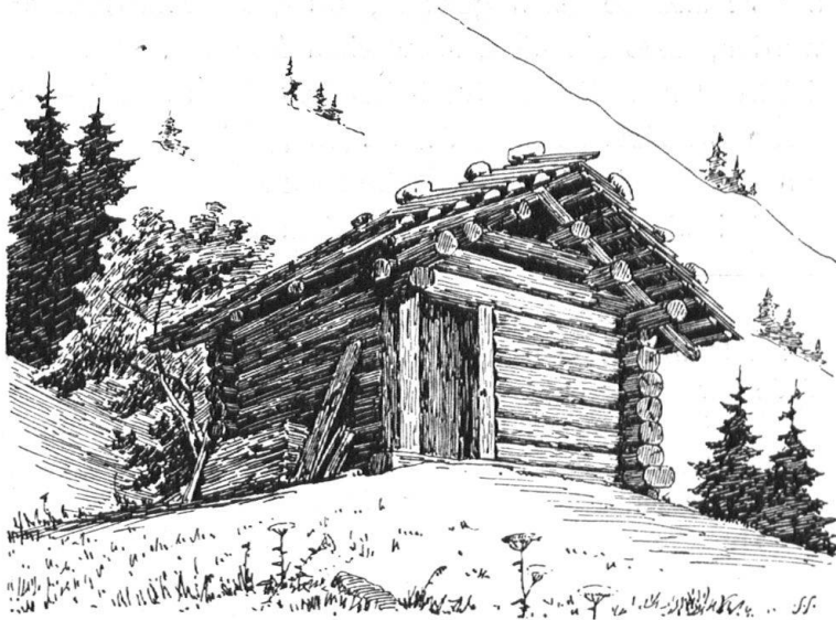
Abb. 1. Kochhüttchen auf Plinezaplana ob Seewis-Prättigau. Aufgetrüllt, katzbäumet, Schwerdach. Nach einer Federzeichnung von Salomon Schlatter. Fig. 1. Chalet-refuge, à Plinezaplana sur Seewis, en Prättigau. Parois formes de troncs non équarris. Toit de bardeaux chargé de pierres.
