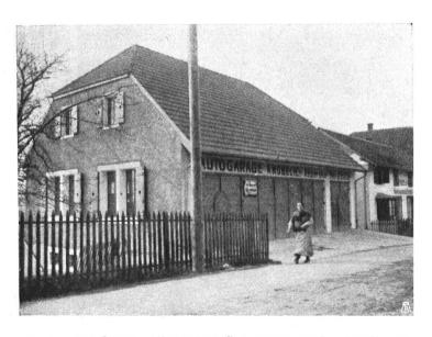
Abb. 12. Die Garage. Mit wenigen Änderungen gemäss dem Heimatschutzvorschlag gebaut. Man beachte das Dach, die Gestaltung der Türen und die Verteilung der Fenster. — Fig. 12. Le garage, élevé avec peu de modifications d'après le projet du Heimatschutz. Remarquer les formes du toit, des portes et la répartition des fenêtres.
