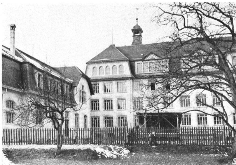
Abb. 18. Südfassade des Moosmattschulhauses zu Luzern. Die Turnhalle ist dem Hauptbau so angegliedert, dass schon um die Mittagszeit eine Reihe von Schulzimmerfenstern im Schatten liegt. — Fig. 18. Façade méridionale de l'école de la Moosmatt à Lucerne. La halle de gymnastique est si malheureusement placée qu'à midi déjà elle jette son ombre sur toute une rangée des fenêtres de classes.
