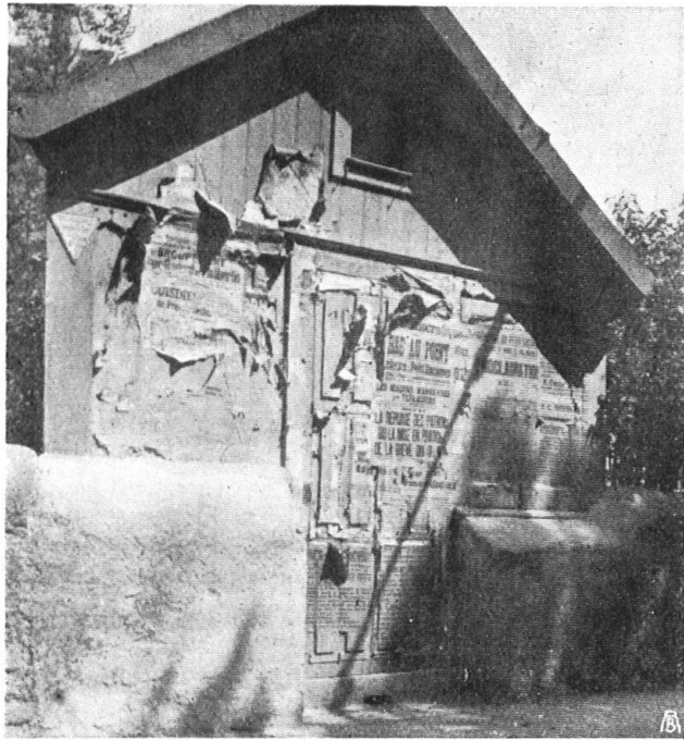
Abb. 2. Schlechtes Beispiel. Wie ein zur Plakatwand gewordenes Gebäude aussieht, wenn weder eine Behörde noch eine verantwortliche Gesellschaft sich des Reklamewesens annimmt. Fig. 2. Mauvais exemple. Affiches placées au hasard sur emplacement toléré par l'autorité. Les affiches non entretenues pendent lamentablement en défigurant l'immeuble et le quartier.
