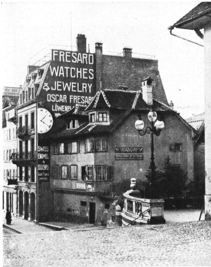
Abb. 14. Hässliche Reklame an einer Hausmuer in unmittelbarer Nähe der Hofkirche zu Luzern. Trotz Einspruch des Heimatschutzes nicht beseitigt. — Fig. 14. Affreuse réclame sur une maison non loin de la Hofkirche à Lucerne. Le Heimatschutz a demandé en vain de la faire disparaître.
