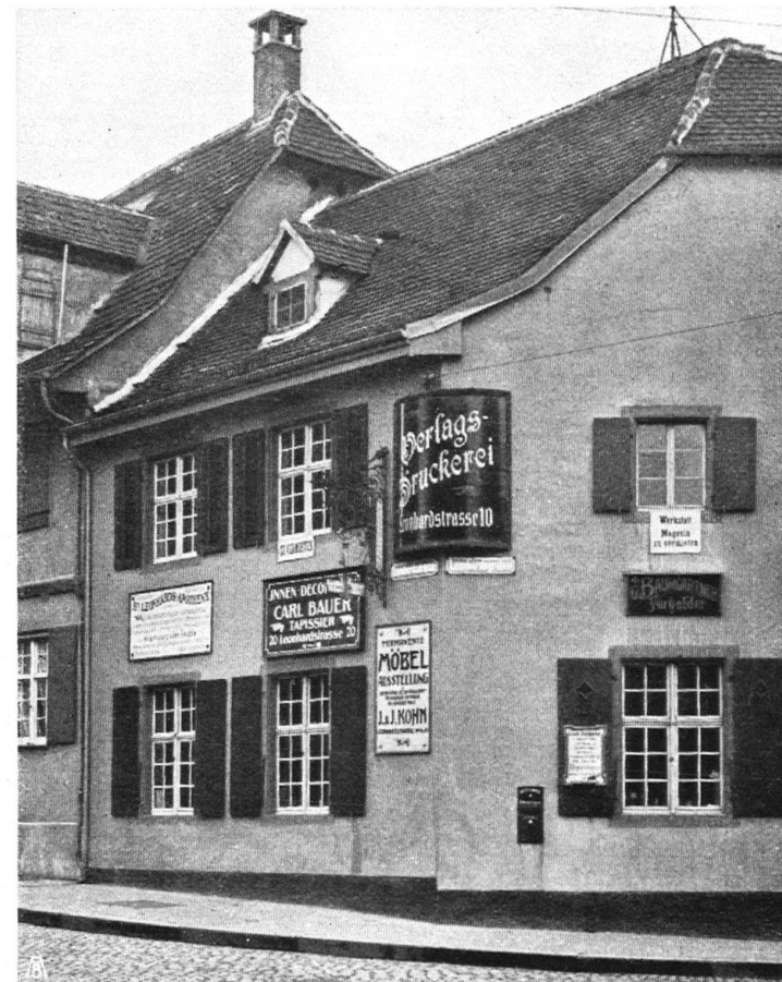
Abb. 20. Schlechtes Beispiel. Mit Firmentafeln überladenes Haus. Zerrissener Eindruck wegen der Wahllosigkeit in der Anordnung, den Formaten, der Ausführung. — Fig. 20 Mauvais exemple. Façades surchargées d'enseignes et d'écriteaux disparates.
