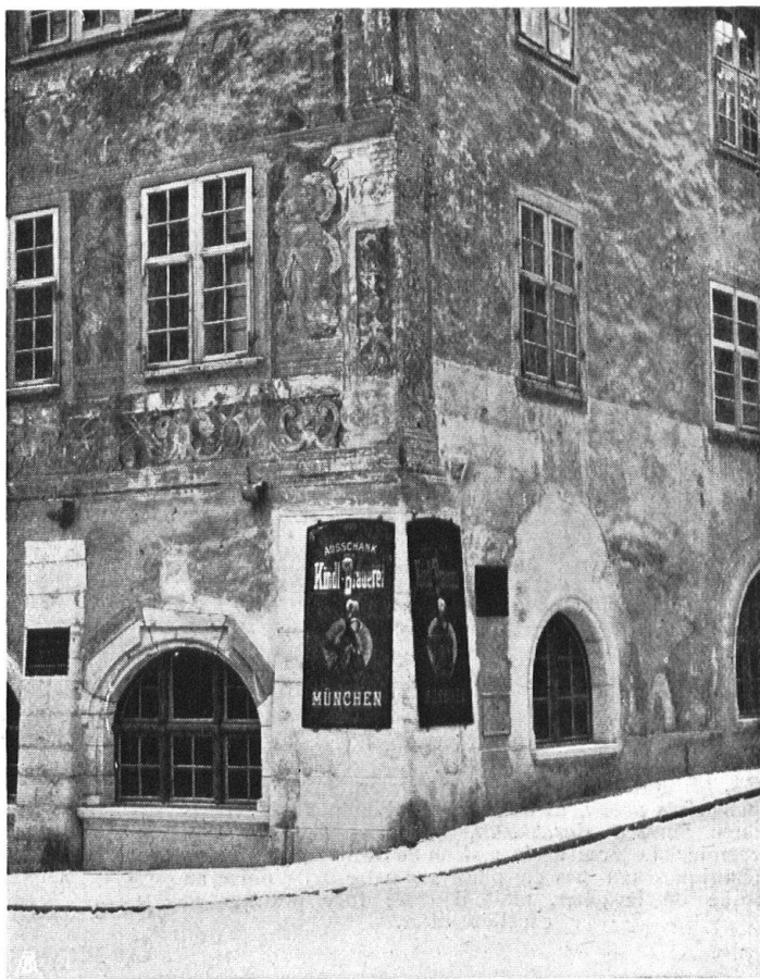
Abb. 15. Störende Glastafeln am freskengeschmückten Hause zum Ritter in Schaffhausen. Die Reklamen sollen auf Ersuchen des Heimatschutzes wieder entfernt werden — Fig. 15. Réclames sur verre dont le voisinage nuisait fort aux fresques de la maison „zum Ritter“ à Schaffhouse et qui seront supprimées grâce aux efforts du Heimatschutz.
