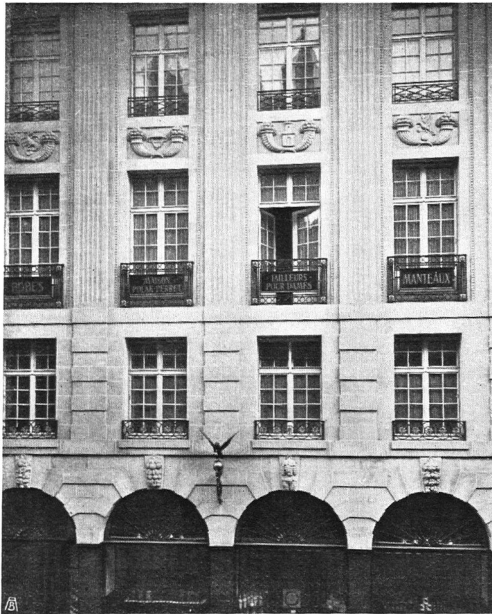
Abb. 19. Firmentafeln an den Fenstergittern eines Geschäftshauses vorbildlich eingefügt. Architekten Suter & Burckhardt, Basel. — Fig. 19. Bon exemple d'enseignes de magasin qui cadrent fort bien avec le caractère général du bâtiment.
