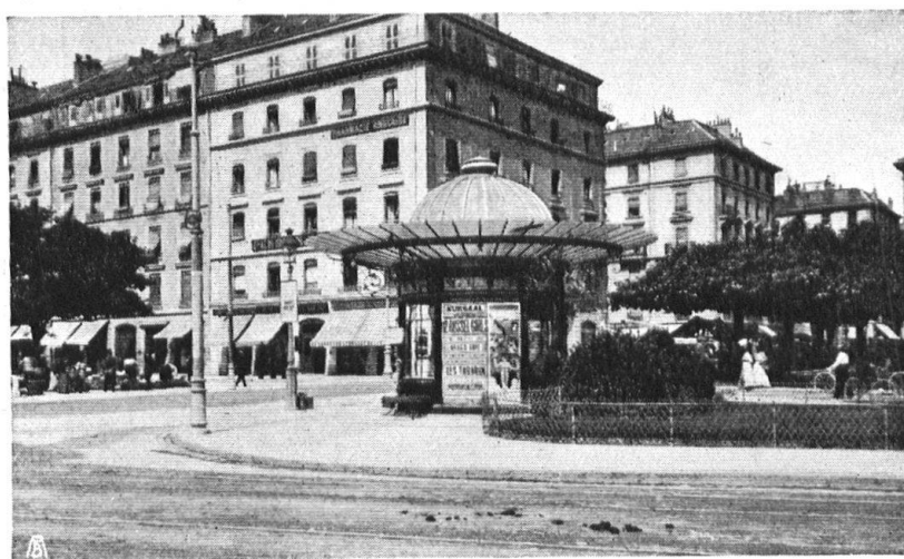
Abb. 5. Gutes Beispiel. Ein Kiosk, der im Strassenbild nicht stört, dient dem Plakataushang und zugleich als Tramwartestelle usw. (Genf.) — Fig. 5. Bon exemple à Genève. Quatre services réunis en un seul édicule: affichage, vente de journaux, station de tramways et urinoir au sous-sol.
