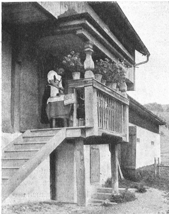
Abb. 9. Laube eines Bauernhauses in Willerzell. Schön geformte Streben. — Fig. 9. Galerie en bois d'une maison de paysan à Willerzell. Remarquer les formes élégantes des colonnes.
