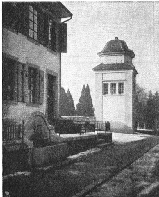
Abb. 19. Transformatorenhäuschen. Gutes Beispiel eines Nutzbaues, nach Entwurf von Bauverwalter Vogt. Aufnahme von K. Ramseyer. — Fig. 19. Poste de transformateurs. Bon exemple d'une construction utilitaire, d'après le projet de M. Vogt.
