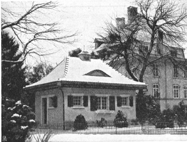
Abb. 18. Öffentlicher Abort auf dem Casinoplatz. Das, besonders auch in der Dachsilhouette, gelungene Häuschen wurde 1913 vom Stadtbauamt (Stadtbauverwalter Vogt) errichtet. Aufnahme von W. Hergert, Aarau. — Fig. 18. Vespasienne sur la Place du Casino. L'édicule, très réussi, surtout dans la silhouette du toit, a été construit en 1913 par le Bureau des constructions de la Ville, dirigé par M. Vogt.
