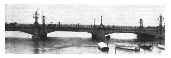
Abb. 17. Die Quaibrücke in Zürich. Die schöne Wirkung der weitgespannten eleganten Brückenbogen ist völlig beeinträchtigt durch die horizontal gerichtete Masse von Gussröhren, welche durch die Bogen gelegt wurden. Aufnahme von R. Ganz, Zürich. – Fig. 17. Le pont du Quai à Zurich. La courbe élégante des arches du pont est complètement déformée par les énormes tuyaux de fonte et leur masse droite et brutale.
