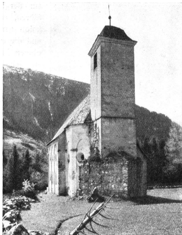
Fig. 11. Eglise de Saint-Placi à Disentis. Devant la tour un mur protecteur contre les avalanches et les chutes de pierres. Le toit de l'église est recouvert de bardeaux, celui du clocher l'est de dalles de pierre.
