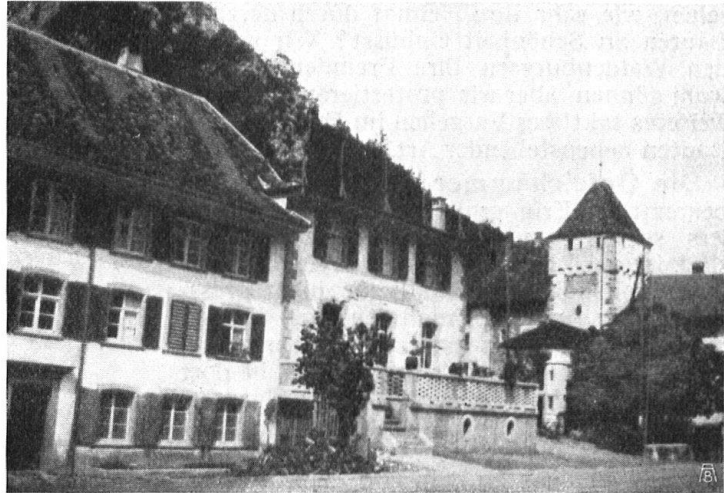
Abb. 22. Landesfremder Neubau in Waldenburg. Der dachlose Bau mit seiner Zementterrasse wirkt neben dem „Törchen“ und dem Nachbarhause als beklagenswerte Schädigung des Ortsbildes. — Fig. 22. Nouvelle construction à Waldenburg, style parfaitement étranger au pays. Le toit plat et la terrasse en ciment offrent un fâcheux et fort désagréable contraste avec la vieille tour et le paysage pittoresque qui l'entourne.
