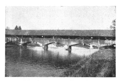
Abb. 16. Alte Thurbrücke bei Weinfelden. Interessanter, wuchtig wirkender Bau; nach der Wetterseite zu seitlich geschlossen. — Fig. 16. Vieux pont sur la Thour, près de Weinfelden. Construction intéressante et d'un bel effet. Fermé par une cloison du côlé de l'ouest.
