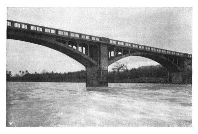
Abb. 17. Neue Thurbrücke bei Weinfelden, mittlerer Teil. Guter moderner Bau in Eisenbeton. — Fig. 17. Nouveau pont sur la Thour, près de Weinfelden. Bonne construction moderne en béton armé.
