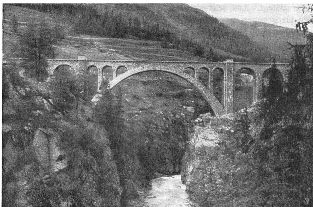
Abb. 4. Inn-Viadukt bei Cinuskel. Einer der schönen weitgespannten Viadukte der neuen Linie nach Bevers-Schuls-Tarasp. Aufnahme von D. Mitschol , Schiers. — Fig. 4. Le viaduc de l'Inn près de Cinuskel. Un des plus beaux viaducs à grande arche de la nouvelle ligne Bevers-Schuls-Tarasp.
