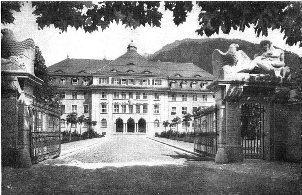
Abb. 19. Das neue Verwaltungsgebäude in Chur. Nach Plänen der Architekten B. S. A. Nic. Hartmann & Cie. in St. Moritz. Klare innere Disposition, die sich auch in den guten Proportionen der Fassade erkennen lässt. Aufnahme von Lienhard & Salzborn , Chur. — Fig. 19. Le nouveau bâtiment de l'administration à Coire, d'après les plans de MM. Nic. Hartmann & Co. , architectes à Saint-Moritz. On peut reconnaître la disposition très claire de l'intérieur aux bonnes proportions de la façade.
