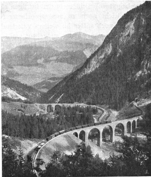
Abb. 2. Entwicklung der Albulabahn zwischen Preda und Bergün, die mit ihrer, dem Terrain angepassten, Linienführung und mit den steinernen Viadukten die Landschaft belebt und bereichert. Aufnahme von Wehrli A.G. in Kilchberg-Zürich. — Fig. 2. La ligne de l'Albula entre Preda et Bergun. En parfaite harmonie avec le paysage auquel elle apporte une vie et une beauté nouvelle, par son viaduc de pierre et ses élégantes lignes onduleuses.
