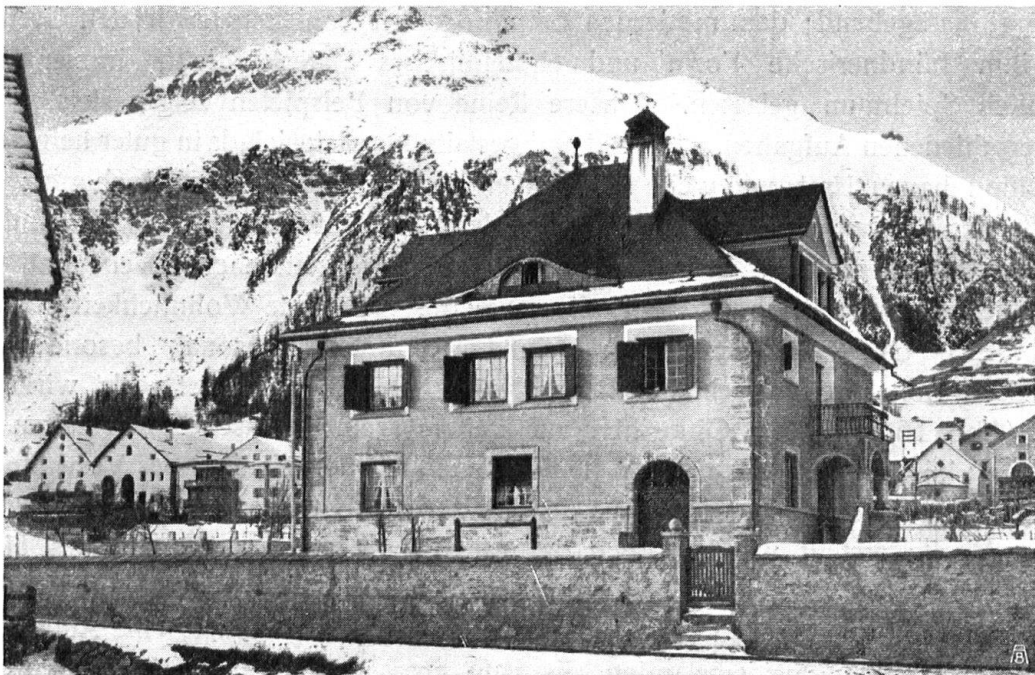
Abb. 14. Sektionshaus in Samaden. Beachtenswert, wie sich der Bau mit seinen grossen und schweren Formen trefflich der Umgebung – heimische alte Bauten und Gebirge – einfügt. – Fig. 14. Bâtiment de l'administration à Samaden. Cette architecture aux formes larges et lourdes correspond parfaitement au style des maisons indigènes et au caractère du paysage montagneux.
