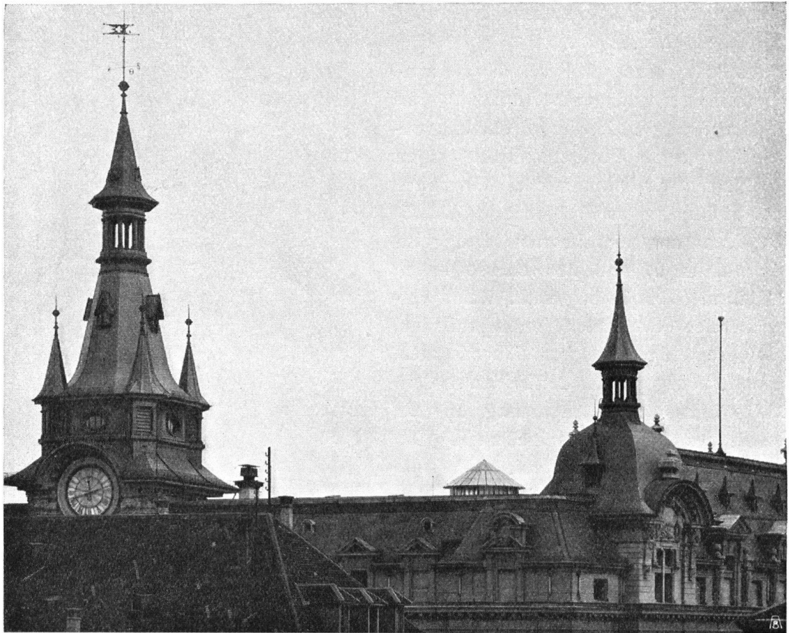
Abb. 5. Zwei Türme des eidgenössischen Postgebäudes in Bern. In missverständener Anpassung an alte Bauten („falscher Heimatschutz“) ist eine Zusammenstellung von Silhouetten und Details entstanden, welche neben den Vorbildern (Abb. 6 und 7) durchaus unkünstlerisch wirken. – Fig. 5. Deux tours de l’Hôtel des postes de Berne. Une inintelligente adaptation aux édifices de vieux style (faux Heimatschutz) a produit un ensemble de silhouettes et de détails d’une valeur artistique infiniment inférieure aux modèles inspirateurs. (Fig. 6 et 7.)
