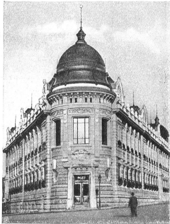
Abb. 3. Eidg. Postgebäude in Basel. Eine Steinmasse von erdrückender Schwere. — Fig. 3. Hôtel des postes fédérales de Bâle. Cube de maçonnerie d'une lourdeur écrasante.
