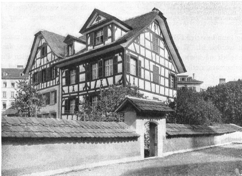
Abb. 11. Kaplanenhaus in Luzern. Durch Abschlagen des Verputzes in den ursprünglichen Zustand versetzt; gut renoviert durch das Stift im Hof. Aufnahme von N. Hinder , Luzern. — Fig. 11. La «Maison des chapelains» à Lucerne, à laquelle on a rendu son aspect primitif après en avoir éloigné le crépi. Bon exemple de restauration. Cliché N. Hinder , Lucerne.
