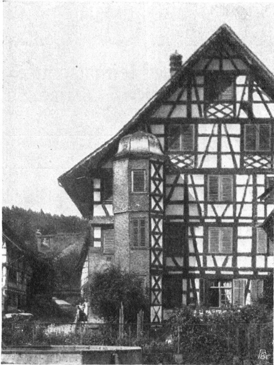
Abb. 2. Das stattliche Wirtshaus zum Hirschen in Oberstammheim. Aufnahme von Hausamann in Heiden. Fig. 2. L'auberge «zum Hirschen» à Oberstammheim. Cliché Hausamann , Heiden.
