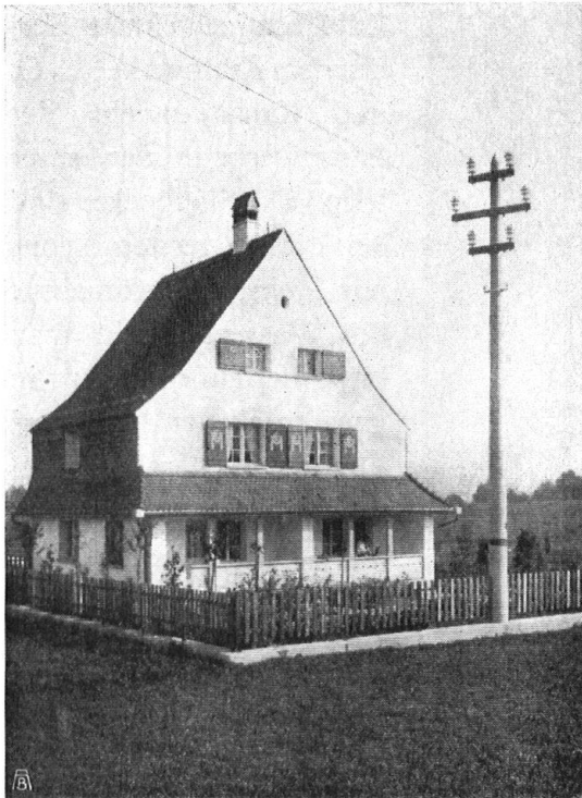
Abb. 10. Beispiel. Eleganter Leitungsträger des Albulawerkes, bei Rüti, Zürich, nebst heimeligem Wärterhaus Aufnahme der Verwaltung des Elektrizitätswerkes der Stadt Zürich. — Fig. 10 Bon exemple. Pilier élégant des installations électriques de l'Albula à Rüti, près Zurich. A côté une charmante maison de garde.
