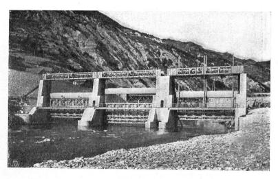
Abb. 13. Rhonewehr bei Leuk. Ehrlich zweckmässige Anlage, harmonische Einfügung, schöne Eisenkonstruktion. Aufnahme des Bureau für schweiz.
