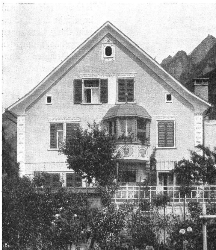
Abb. 7. Wohnhaus Râth in Chur. Umgebaut durch die Architekten B. S. A. Schäfer und Risch, Chur. Bedeutender Raumgewinn, hochragender Giebel, Zusammenfassung der Fenster, Abgrenzung gegen Nebengebäude, Erker von guter Rasse. — Fig. 7. Maison Râth à Coire. Transformée par les architectes B. S. A. Schäfer et Risch à Coire. On remarquera l'espace gagné, l'élancement du pignon, l'encadrement des fenêtres, le style du bow-window, et la prédominance donnée à la masse du bâtiment principal sur celle de l'annexe.
