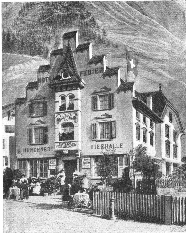
Abb. 13. Hotelbau in der üblichen Similigotik vom Anfang des 20. Jahrhunderts. Vor dem Umbau. (Vgl. Abb. gegenüber.) – Fig. 13. Hôtel construit dans le pseudo-gothique en usage au commencement du XX me siècle; avant la transformation (cf. vis-à-vis).
