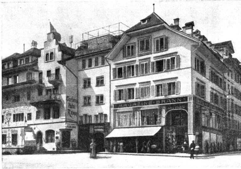
Abb. 2. Umbauten in Luzern. Eckhaus. Schlechtes Beispiel: ein altes Bürgerhaus wurde durch Herausreissen der Basis und deren rücksichtsloses Ersetzen durch Eisen und Glas verunstaltet, daneben ein zweites durch Beseitigung des Daches und schlechten Altanenaufbau entsteht. Das letzte Haus in der Reihe hat durch einen guten Dachaufbau in der Silhouette entschieden gewonnen. — Fig. 2. Transformations à Lucerne. Maison d'angle, mauvais exemple: une vieille demeure bourgeoise a été défigurée par la démolition des étages inférieurs et leur reconstruction en fer et verre. Dans la maison voisine l'aplanissement du toit transformé en terrasse a aussi mutilé l'édifice. Par contre, le relèvement de la toiture a amélioré la silhouette de la dernière maison de gauche.
