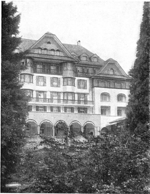
Abb. 17. Hotel in Weggis, umgebaut durch die Architekten B. S. A. Möri und Krebs, Luzern. Gewinn an Raum, Licht und Luft, wie an Gesamtwirkung, Form und Gliederung des Hauses. (Vgl. Abb. 18.) – Fig. 17. Hôtel à Weggis, après sa transformation par les architectes B. S. A. Möri et Krebs, Lucerne. Gain en espace, en lumière et en air; l'aspect général, la forme, le rapport des masses sont meilleurs.
