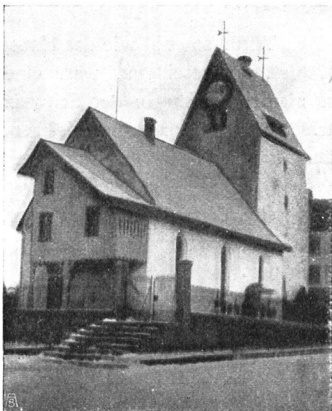
Abb. 20. Kirche in Fehraltorf vor dem Umbau. (Vgl. Abb. 19.) — Fig. 20. L'église de Fehraltorf avant la transformation. (cf. ill. 19).
