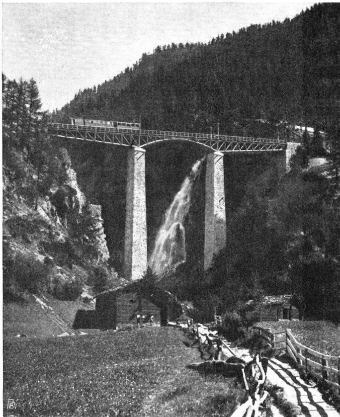
Abb. 2. Die Findelenbachbrücke der Gornergratbahn. Die Eisenkonstruktion auf den Steinpfeilern bietet keine schöne Massenwirkung; sie erscheint als etwas Fremdes, Zerrissenes in der Landschaft. Aufnahme von Wehrli A.-G., Kilchberg. — Fig. 2. Le pont de fer lourd et raide jeté sur deux piliers de pierre et qui coupe brutalement le paysage est en complète disharmonie avec celui-ci. Cliché Wehrli S. A., Kilchberg.
