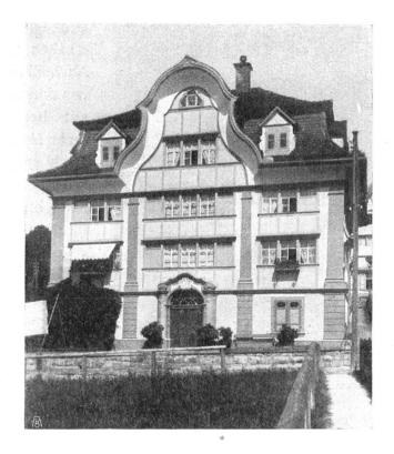
Abb. 14. Bürgerhaus in Gais. Aus dem 18. Jahrhundert. Die aus der Fremde stammenden Barockformen (dreiteilige Gliederung der Fassade durch Pilaster, Mansarddach, Giebel, Portal) werden mit der einheimischen Bauweise geschickt verbunden. Phot. Hausammann, Heiden.
