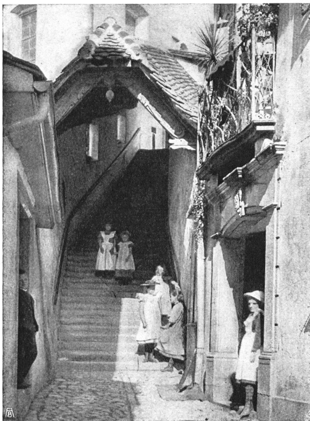
Abb. 2. Kapuzinertreppe. Interessante Details an der hölzernen Dachkonstruktion der gedeckten Treppe. Im Vordergrunde rechts eine architektonisch beachtenswerte Haustüre. Aufnahme von Wehrli A.-G., Kilchberg. — Fig. 2. Escalier des Capucins. Remarquer le toit en bois de l'escalier qui offre des détails intéressants. Au premier plan, à droite, une porte d'entrée d'une architecture originale. Cliché Wehrli S. A., Kilchberg.
