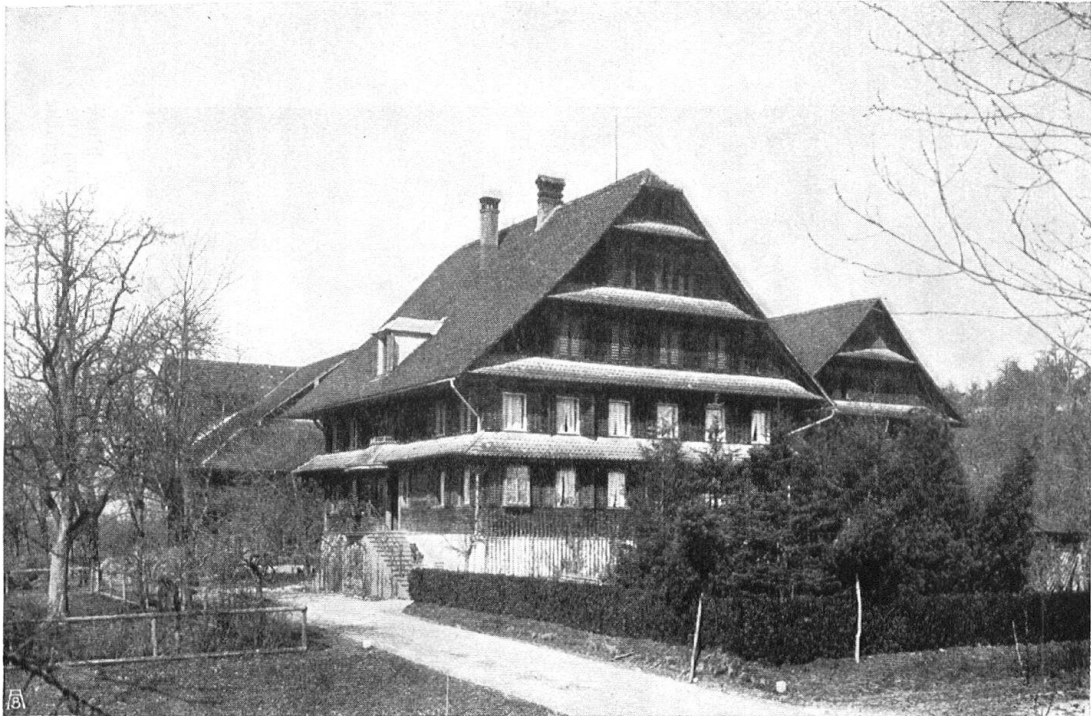
Abb. 19. Bauernhaus im Lüssi bei Zug. Sog. Ständerbau mit den für die Zuger Gegend typischen Vor-dächern an der Giebelseite. — Fig. 19. Ferme au Lussi, près Zoug. Bâtiment caractéristique pour les environs de Zoug, par ses avant-toits sur la façade du pignon.
