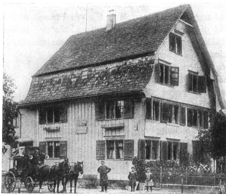
Abb. 7. Gutes Beispiel. Die Post in Roggwil (Thurgau). Beachtenswert die guten Verhältnisse von Flächen zu Fenstern, der schöne Schwung der Dachlinie. — Fig. 7. Bon exemple. Le bâtiment des postes à Roggwil (Thurgovie). Remarquer surtout l'excellente proportion qui règne entre les fenêtres et la façade, et la courbe élégante du toit.
