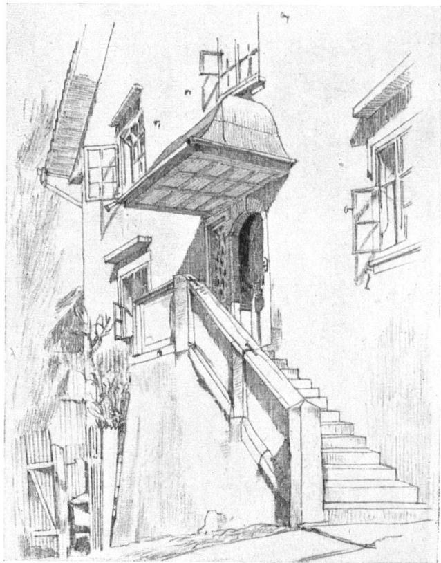
Abb. II. Treppenaufgang zum Haus im Rain in Zollikon. Beachtenswert das edelgeformte Vordach über der Türe, die Schutzsimse über den Fenstern. Nach einer Bleistiftzeichnung von Architekt Fietz, Zürich. — Fig. II. Escalier d'entrée de la maison «im Rain» à Zollikon. Remarquer l'avant-toit qui protège la porte, et la corniche au-dessus des fenêtres. D'après un dessin de M. Fietz, architecte, à Zurich.
