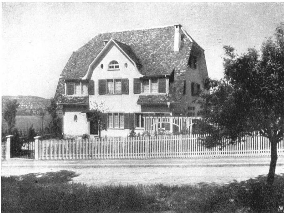
Abb. 10. Haus Rübéli in Kilchberg. Ein guter moderner Bau, aus der altzürcherischen Tradition herausgewachsen, aber ohne sie sklavisch zu kopieren. Photographie Link , Zürich. Fig. 10. Maison Rübéli à Kilchberg. Bonne construction moderne inspirée par d'excellentes traditions zurichoises, mais sans les imiter servilement. Photographie de M. Link , à Zurich.
