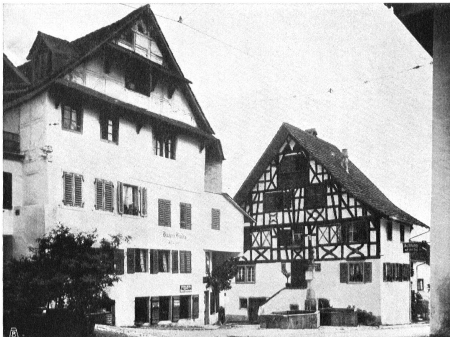
Abb. 4. Häusergruppe in Grüningen. Das Haus im Vordergrund imposant durch seine Masse, originell im Dachaufbau und in der Ecklösung. Das Riegelhaus hinter dem währ- schaften Brunnen zeigt dekorativ verwendetes Holzwerk. Photographie von H. Fietz, Zürich. Fig. 4. Groupe de maisons à Grüningen. La maison au premier plan se distingue par ses formes massives et imposantes, sa toiture et l'heureuse combinaison des lignes d'angle. La construction en colombage derrière la fontaine est d'un dessin remarquable. Photographie de M. H. Fietz, à Zurich.
