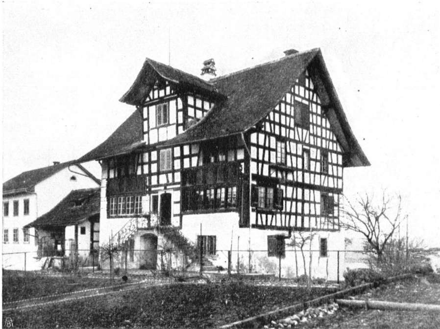
Abb. 3. Haus in Hombrechtikon. Schöner Riegelbau mit Reihenfenstern und Teilpartien mit kunstvoll bearbeitetem Holzwerk. Die Freitreppe schmückt ein schönes Schmiedeisen- gitter. Photographie von H. Fietz, Zürich. — Fig. 3. Maison à Hombrechtikon. Belle construction en colombage. Disposition caractéristique des fenêtres. Poutres artistiquement sculptées. Belle grille en fer forgé. Photographie de M. Fietz, à Zurich.
