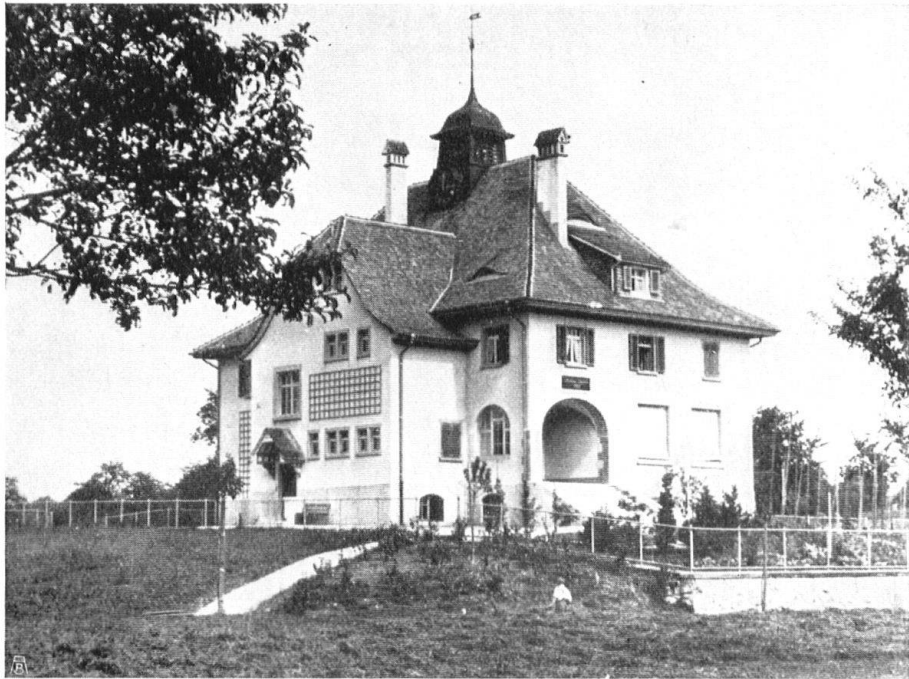
Abb. 9. Schulhaus Stocken-Horgen. Heimelige Bauweise unter Benützung alter Motive, dem modernen Zweck aber doch völlig gerecht werdend. Photographie von J. Abend . Fig. 9. Ecole de Stocken-Horgen. Bâtiment très réussi. L'architecte, tout en empruntant des formes anciennes, a su les combiner de manière à remplir le but proposé. Photographie de M. J. Abend .
