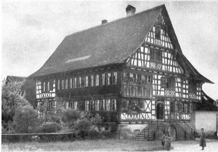
Abb. 2. Wirtshaus in Oberaach. Typus des thurgauischen Riegelbaues, mit Erinnerungen an die vorausgegangene reine Holzarchitektur.
