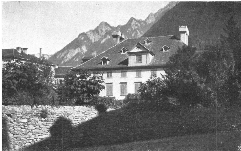
Das Alte Gebäu (von Salis'sches Haus). Blick von der Gartenseite. Hier dominiert besonders das mächtige Dach, belebt durch Kamine und Dachlücken in originellen Formen. Auf dieser Seite ist der Dekor noch schlichter als an der Hauptfassade. Man beachte, wie wundervoll sich die kräftige Silhouette in das von Bergen umrahmte Landschaftsbild einfügt. — Maison «von Salis» vue du jardin. Ici domine avant tout le toit animé par des cheminées et des lucarnes d'une forme originale. La façade de ce côté est plus simple encore que de l'autre. Remarquer avec quelle vie la vigoureuse silhouette se détache de la montagne.
