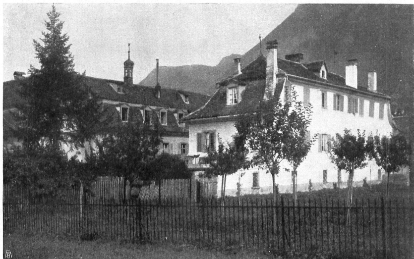
Das ehemalige von Salis'sche Haus an der Masanserstrasse; von der Quaderwiese aus gesehen. Ein in der ganzen Gruppierung einzigartiger und gross angelegter Bau aus der Zeit um 1770. ::
