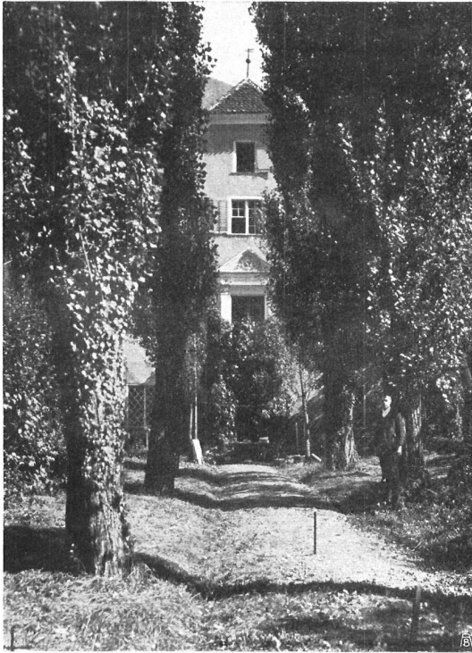
Turligartenhaus (Haus Secchi) von der Allee im Garten aus gesehen. Malerische Gesamtwirkung von Gebäude und Baumreihen. Beachtenswert die reiche Ausbildung des Portals. — Maison du Turligarten (maison Secchi) vue de l'allée du jardin. La maison et l'allée offrent un ensemble pittoresque. Remarquer la riche ornementation du portail.
