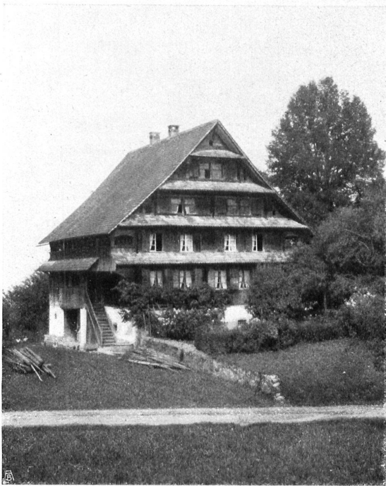
Abb. 5. Bauernhaus in Oberrisch, Kanton Zug. Datiert 1792. Fig. 5. Ferme à Oberrisch, canton de Zoug. Porte la date de 1792.
