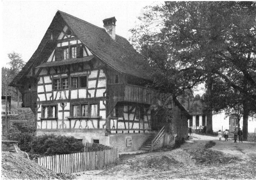
Abb. 13. Steghof in Luzern. Typischer Riegelbau. Aufnahme von N. Hinder, Luzern. — Fig. 13. Steghof à Lucerne. Exemple typique de construction en colombage. Cliché N. Hinder, Lucerne.
