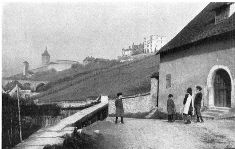
Oestlicher Eingang zur Stadt. Das Bruchthalgässli, zwischen Weinbergmauern geführt, soll aus Verkehrsrücksichten einer Korrektur unterzogen werden. — L'entrée Est de la ville. La route de Bruchthalen, bordée de murs de vignobles, va être corrigée pour faciliter la circulation.
