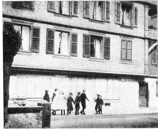
Dasselbe Haus in Sarnen, nach dem verschönernden Umbau, der ihm alles Charakteristische raubte. — La même maison à Sarnen après une reconstruction qui lui a enlevé tout son charme caractéristique.
