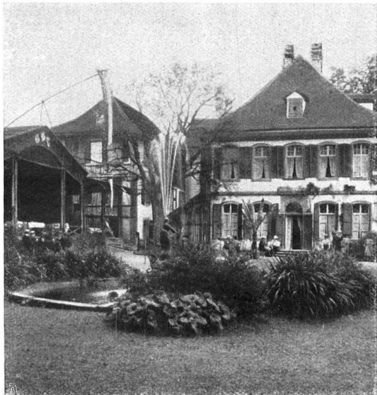
Blick in den Garten. Im Hintergrund die Südfront des Hauses mit dem fatalen Anbau nach Westen. Links die alles verderbende Trink- halle mit Flagge Vue du jardin. Face sud de la maison; à gauche une malheureuse buvette avec oriflamme
