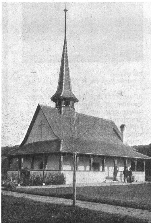
Die Friedhofskapelle in Sumiswald Arch. B. S. A. Karl In der Mühle, Bern
