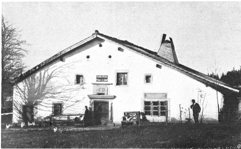
FERME DATANT DE 1612, A LA CHAUX-D'ABEL. Porte et fenêtres intéressantes. Inscription au-dessus de la fenêtre à gauche: «La bénédiction de Dieu demeure en ceste maison éternellement.» — Phot. J. Arn, St-Imier
