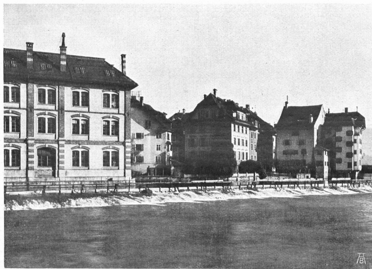
ALT- UND NEU-LUZERN. In unmittelbarer Nähe der schönsten alten Bürgerhäuser ein hässlicher fabrikmässiger Nutzbau in Backsteinverblendern. — Aufnahme von E. Synnberg & v. Pflyffer, Luzern. LE VIEUX LUCERNE ET LE NOUVEAU LUCERNE. Tout près de belles vieilles maisons bourgeoises s'élève la maison de rapport moderne. — Cliché de Synnberg & v. Pflyffer, Lucerne.
