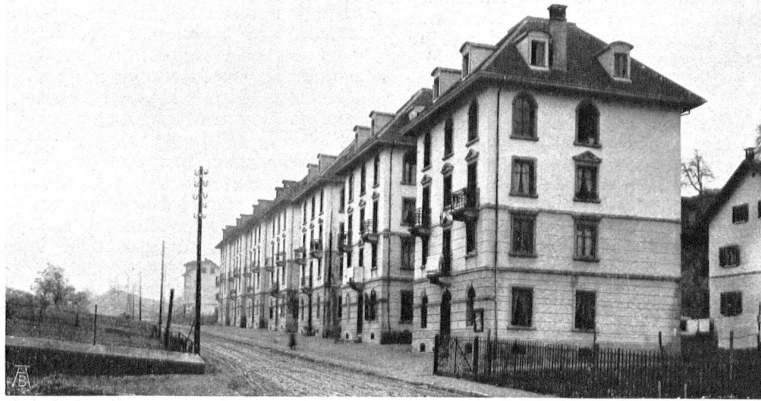
GEGENBEISPIEL: Moderne schlechte einfache Wohnhäuser von tödlicher Einförmigkeit an der Bernstr. MAUVAIS EXEMPLE: Maisons d'habitation à la Bernstrasse
