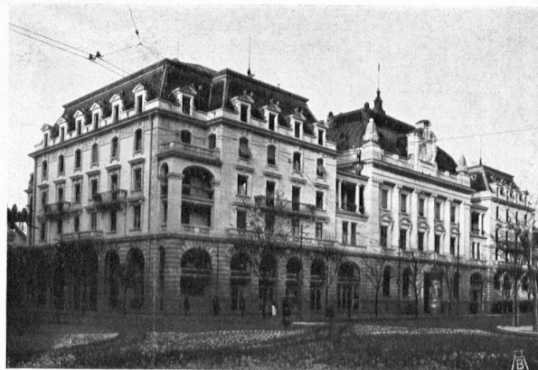
GEGENBEISPIEL: Ein neues öffentliches Gebäude, trotz grössten Schmuckaufwandes doch von geringer Wirkung und durch zwei „organisch“ (?) angebaute reizlose Miethäuser erdrückt MAUVAIS EXEMPLE: Un édifice public, flanqué de deux maisons de rapport. Le tout surchargé d'ornements
