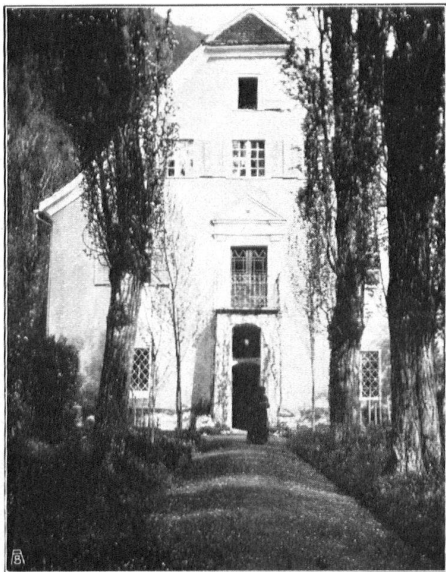
ALTES HERRSCHAFTSHAUS IN CHUR. Ansicht vom Garten aus. Photographie von Architekt Schäfer in Chur. == MAISON PATRICIENNE A COIRE, vue du jardin ==
