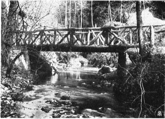
BEISPIEL: Im romantischen Park ist die Naturholzbrücke von einfacher Zeichnung und aus starken Hölzern angefertigt, berechtigt und wirkungsvoll. BON EXEMPLE: Le pont en bois naturel, simple et solide, se justifie parfaitement dans ce milieu sauvage
