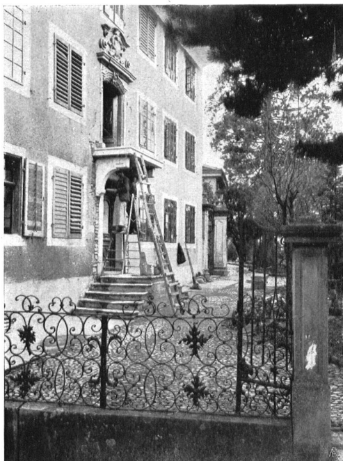
Die Strassenfassade. Der alte Balkon samt Balkontüre und Hauptportal ist ins Ausland verkauft. Das Bild zeigt wie ein neuer Balkon für den zum Verkauf herausgebrochenen eingesetzt wird. Façade de la rue. L'ancien balcon, sa porte et le portail principal ont été vendus à l'étranger. Notre photographie montre comment on travaille à remplacer le balcon vendu
