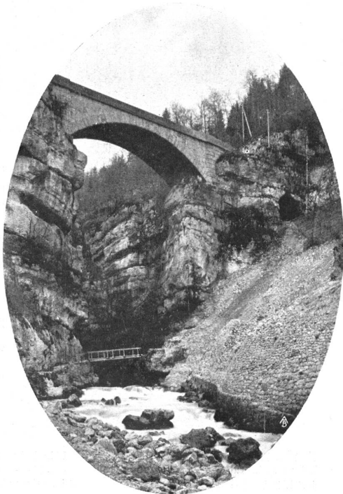
STEINBRÜCKE ÜBER DIE TAUBENLOCHSCHLUCHT Photographie von F. Schönenberger, Bern PONT EN PIERRE DANS LA GORGE DU TAUBENLOCH Photographie de F. Schönenberger, Berne
