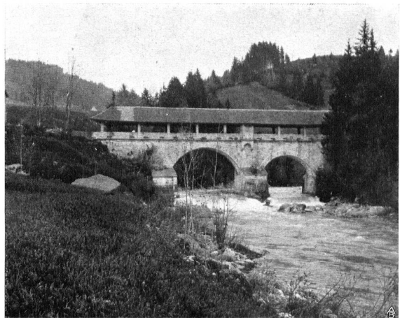
DIE TEUFELSBRÜCKE UBER DIE SIHL BEI EINSIEDELN. Beispiel einer alten gedeckten Steinbrücke. — Photographie von E. Ganz PONT DU DIABLE, SUR LA SIHL, PRÈS EINSIEDELN. Exemple d'un vieux pont couvert, en pierre. — Photographie E. Ganz
