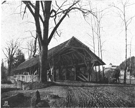
DIE EHEMALIGE ZIEGELBRÜCKE BEI BURGDORF, eine malerische alte Holzbrücke, jetzt durch eine langweilige Eisenkonstruktion ersetzt ANCIEN PONT PRÈS BERTHOUD, en bois, très pittoresque, remplacé par la construction en fer à droite
