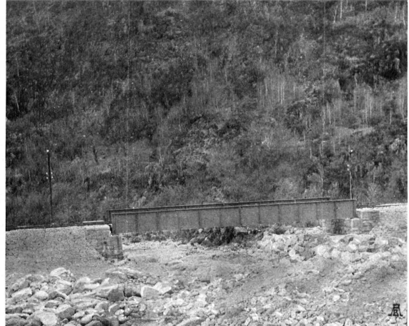
EISERNE BRÜCKE DER MAGGIATALBAHN ÜBER DEN BACH VON AVEGNO, 100 m unterhalb der neben abgebildeten malerischen alten Strassenbrücke aus Stein PONT EN FER DANS LE VAL MAGGIA, à une distance de 100 m du vieux pont reproduit à gauche
