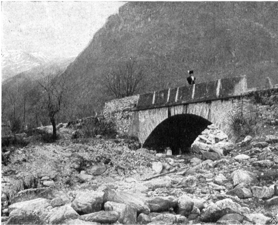
STEINERNE STRASSENBRÜCKE ÜBER DEN BACH VON AVEGNO IM MAGGIATAL. Besonders wirksam im Gegensatz zu der nahen, neben abgebildeten modernen eisernen Bahnbrücke PONT EN PIERRE DANS LE VAL MAGGIA. Le contraste avec le pont du chemin de fer (reproduit à droite) est éloquent
