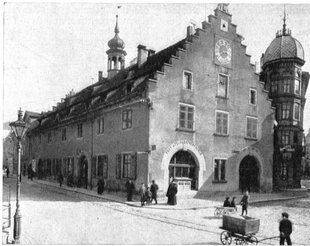
DAS ALTE KAUFHAUS ZU ST. GALLEN bildet einen prächtigen Abschluss des Theaterplatzes und ist fast das einzige alte öffentliche Gebäude der Stadt — ANCIEN ENTREPOT PUBLIC DE SAINT-GALL sur la Place du théâtre, presque l'unique construction municipale de date ancienne
