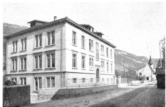
«LANDSCHULHAUS» IN MASANS BEI CHUR, charakteristisch durch seine langweilige, kastenmässige Gestalt und die in keiner Weise länd- lichen Bauformen ÉCOLE DE CAMPAGNE (!) A MASANS PRÈS COIRE. N'a qu'un caractère, celui de l'ennui
