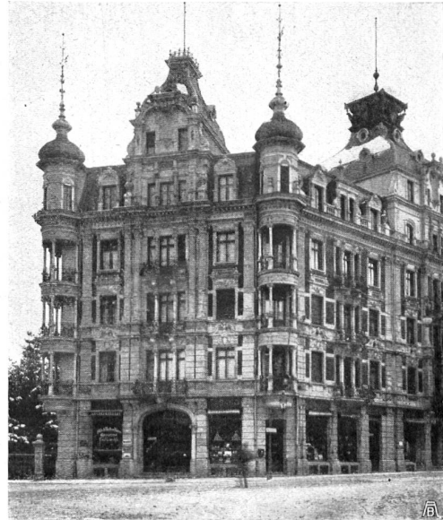
MODERNES HAUS AM FALKENPLATZ (Länggasse) IN BERN in all seiner parvenüemässigen Überladung ein wirksames Gegenbeispiel zu der vornehm reichen Fassade des „Hôtel de Musique“ ===== MAISON MODERNE A LA LÄNGGASSE; richesse de mauvais goût, contrastant avec les lignes si pures de l'Hôtel de Musique ===== Phot. Mettler , Bern
