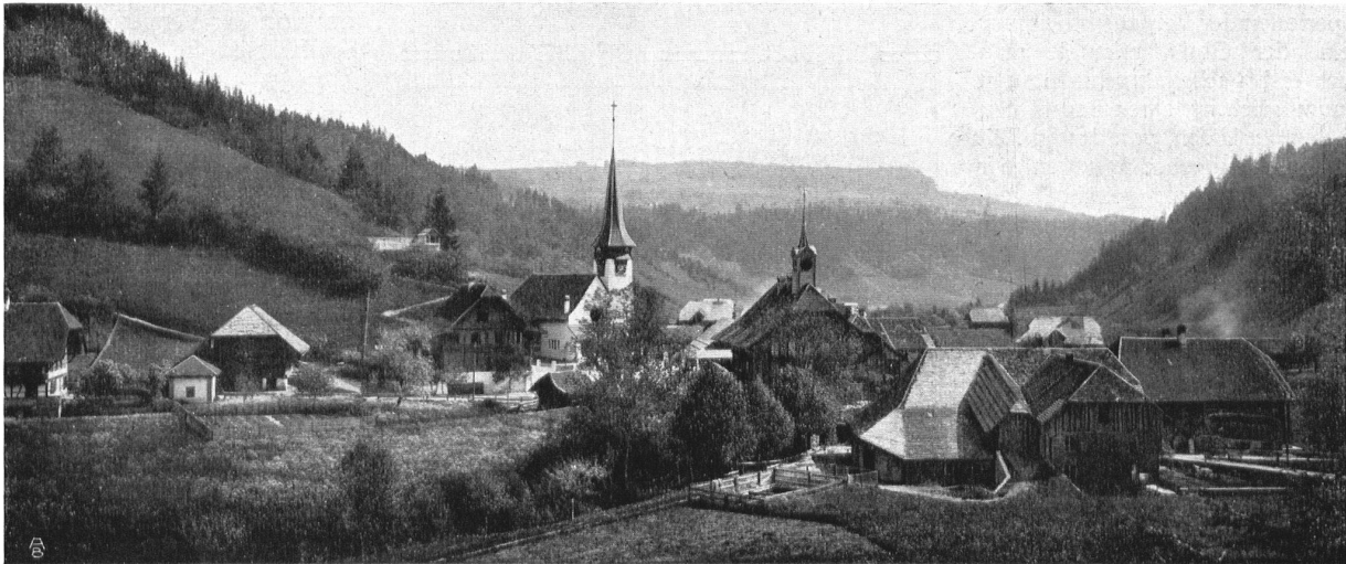
DIE KIRCHE IN RÖTHENBACH im Emmental (Kt. Bern) als Beispiel eines neuen, und doch dem Landschafts- und Dorfbild harmonisch eingefügten Baues.
