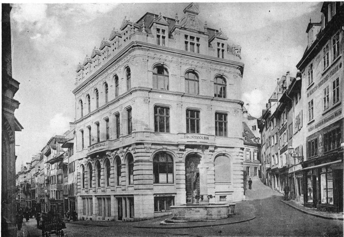
Eidgenössische Bank. Freiestraße. Unharmonisch gegliederter Bau internationalen Gepräges. Unschöne Ecklösung, ohne Rücksicht auf die Umgebung.
