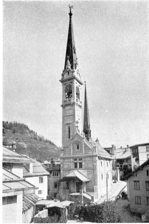
DIE REFORMIERTE KIRCHE IN ST. MORITZ unschön durch die zerrissene Silhouette und den aufdringlichen Formenschmuck L'ÉGLISE RÉFORMÉE DE SAINT-MORITZ, désagréable de silhouette et surchargée d'ornements
