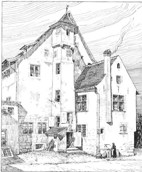
== HOF EINES HAUSES IN BASEL (Albantal 35) == == COUR D'UNE MAISON A BALE (Albantal 35) ==
